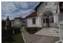
Fig. 2. Zona istorică. Primăria, Școala și Monumentul eroilor, 1923
